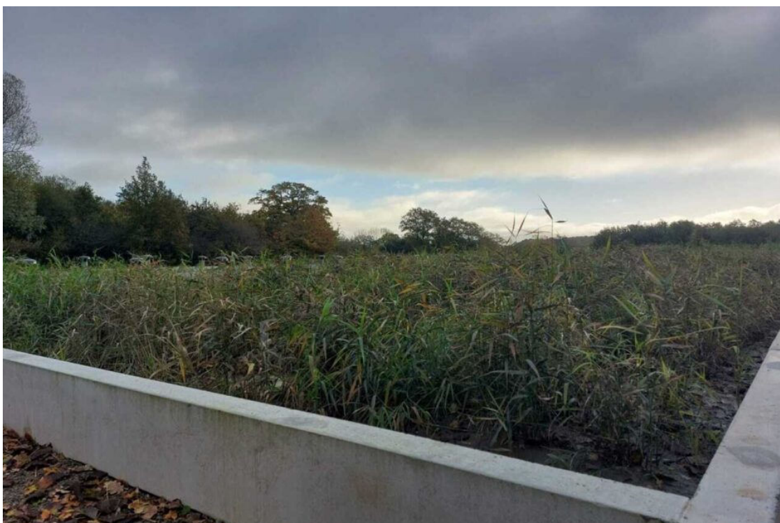
Le traitement des eaux usées est effectué par un système naturel : des roseaux. ©LOrne hebdo
