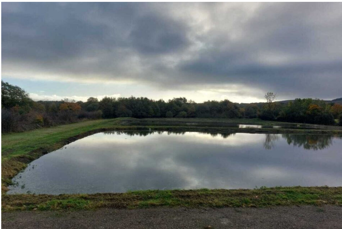
Deux lagunes ont été conservées et affinent le travail de traitement avant de rejeter leau dans le Chédouet. ©L'Orne hebdo
